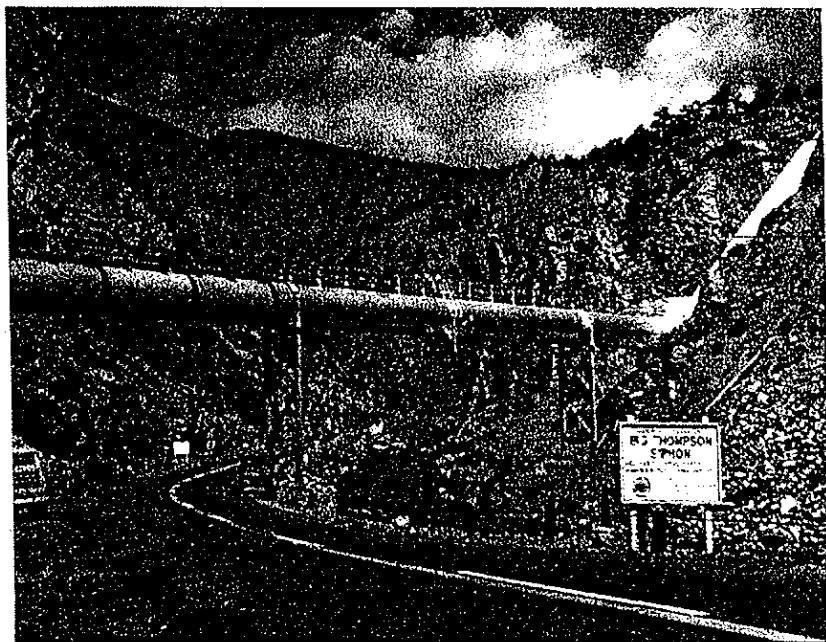
FRANCHISSEMENT D'UNE VALLÉE PAR UN CANAL D'IRRIGATION AUX ÉTATS-UNIS.
