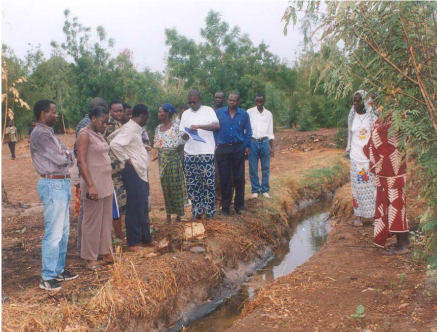
Photo n°1 : Rigole de collecte des eaux usées sur le site de Kossodo
