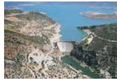
Les barrages jouent un rôle crucial pour le développement économique du Maroc (Photo M. Monbaron)
